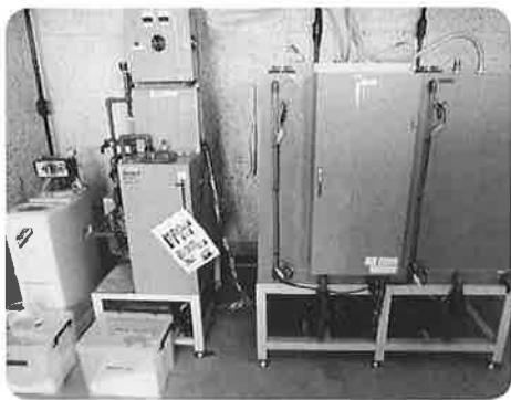
この度、洗浄除菌水生成装置の入れ替えをしました。洗剤を使用せずに水道水と塩から作られた二つの生成水により洗浄、除菌、漂白を行う為、肌への悪影響を及ぼすことなく、二次感染防止にもなります。また、雑菌やノロウイルスなどの繁殖を抑え、施設内環境を衛生的に保つ効果もあります。
