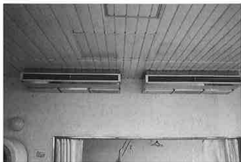
▲管理棟空調設備改修工事を行いました。 食堂・通所室など、より快適に過ごせる よう整備しました。
