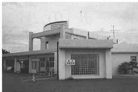
▲17年振りに外壁・屋根の塗装・補修工 事を行いました。利用者さんも「綺麗に なったね!」と喜んでいます。
