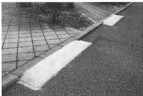
▲鉄板をコンクリートにし、隙間を埋めました。より一層の安全な環境整備に努めてまいります。
