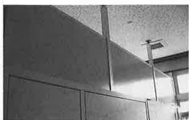
▲安全対策としての居室整備です。地震の際に、頭の上に落ちてきそうなものについて整理していただきました。
