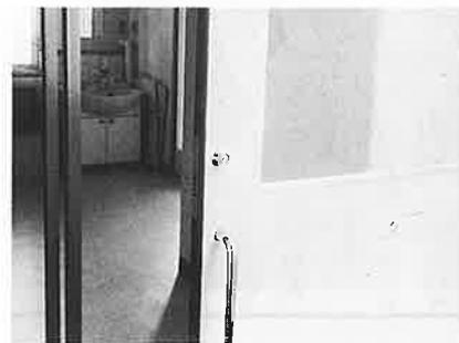
利用者が安全に入浴できるように、脱衣場及び浴室内の段差を解消し、浴室タイルを滑りにくい材質のものとし、便所を洋式に改修する工事を、
